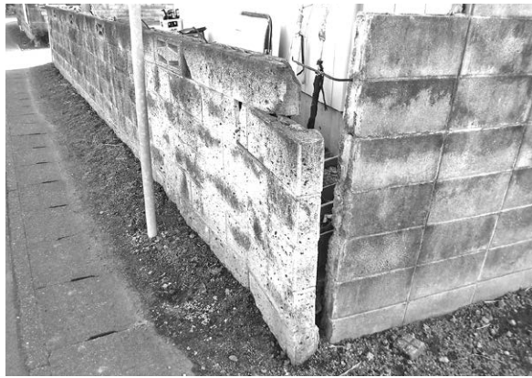
撤去前のブロック塀
