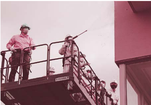
▲体育館外壁清掃作業の様子
