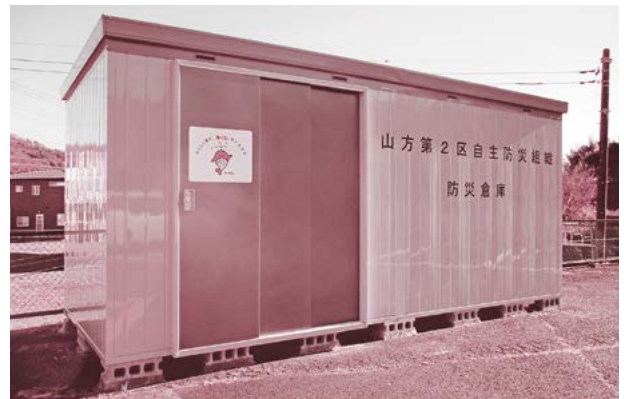
▲今回整備された防災資機材
