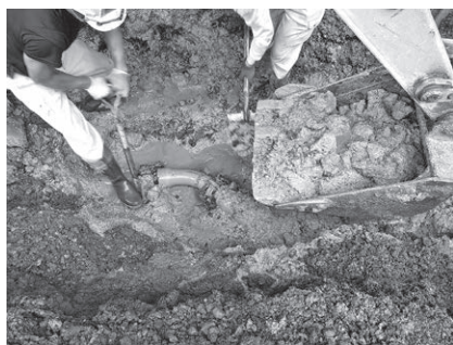
今後増加が予想される漏水修繕作業
