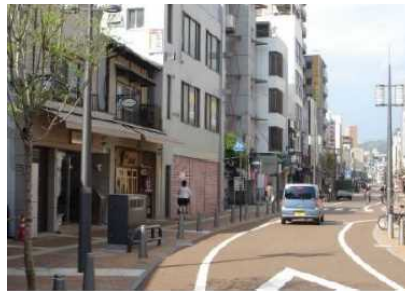
事例：長野県長野市 ベンチの設置（左） 事例：愛媛県松山市 無電柱化（右） （出典：国土交通省 HP）
