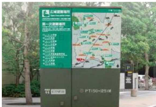
事例：地上機器を装飾(ラッピング方式) (出典：練馬区役所HP)
