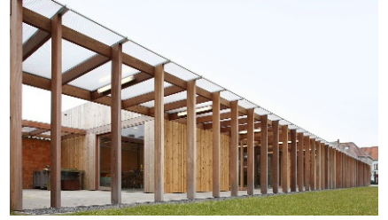
駅からのアプローチに配慮した回廊
