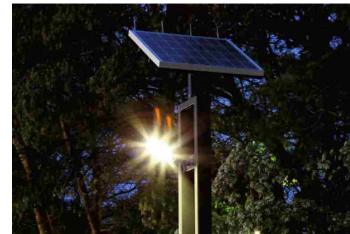
停電時でも利用できるソーラー照明
