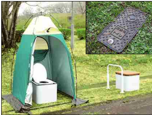
断水しても利用できるマンホールトイレ
