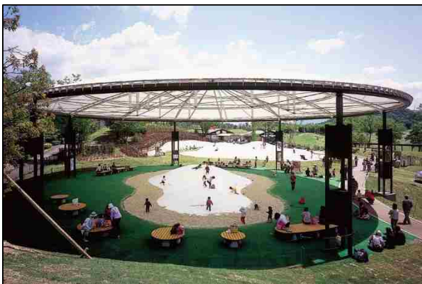
雨や夏の日差しに配慮した遊具広場
