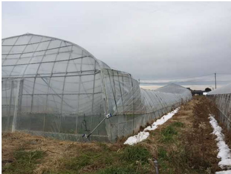
大雪でのハウスの倒壊①
