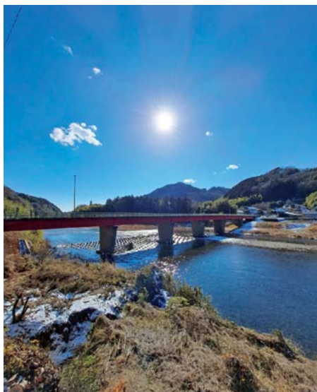
@arenarena414さん撮影 【下小川橋】
