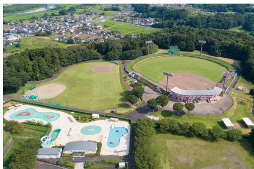
大宮運動公園 全体
