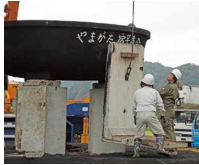
▲クレーン車を使い、かまどや風除けを設置します。機材なども本職で使用しているものを活用し、地元一丸となって準備が進められます。
