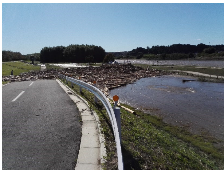
令和元年東日本台風の被害（久慈川辰ノ口堰付近）
