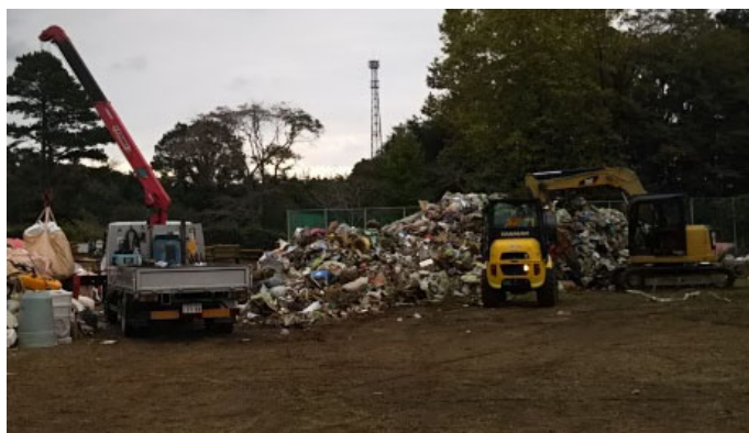
稼働する重機類（旧御前山中学校）
