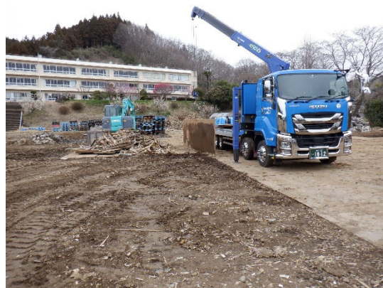
仮置場への鉄板敷き作業の様子（旧御前山中学校）
