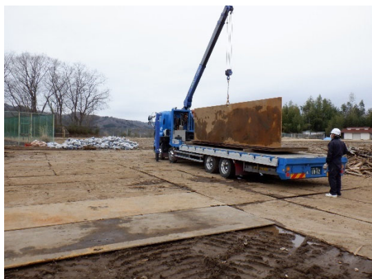
仮置場への鉄板敷き作業の様子（旧御前山中学校）
