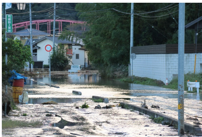
令和元年東日本台風の被害（野口地内）
