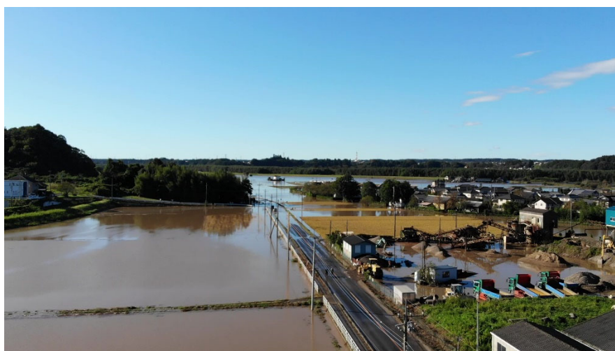
令和元年東日本台風の被害（大宮東部コミュニティセンター付近）
