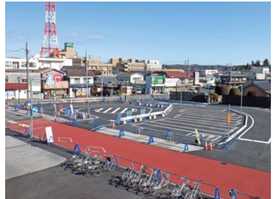
仮設ロータリー
