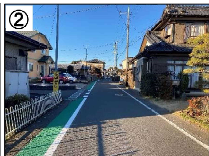
歩行空間整備(カラー舗装)
