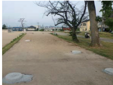
土系舗装による園路（回廊跡） (特別史跡百済寺跡：枚方市)
