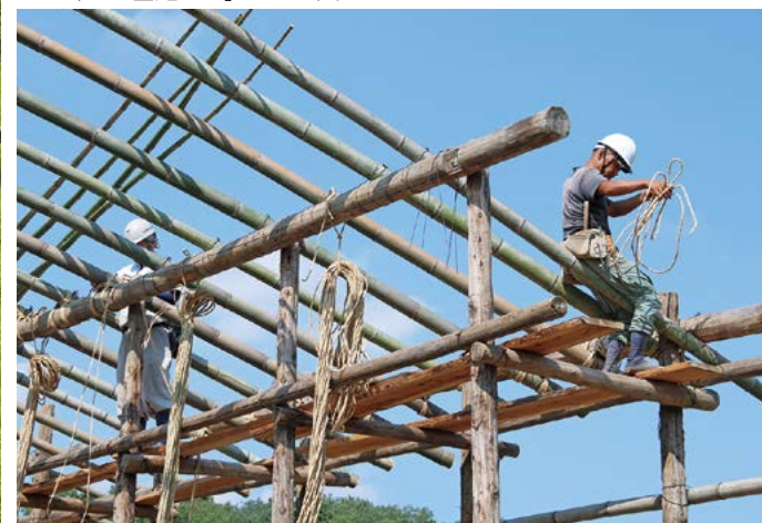
▼舞台の組立てで課題の一つとなっていた高所作業。幅広くボランティアが集まったことで「縄で竹を結び前に針金で固定する」など工夫も生まれました。
