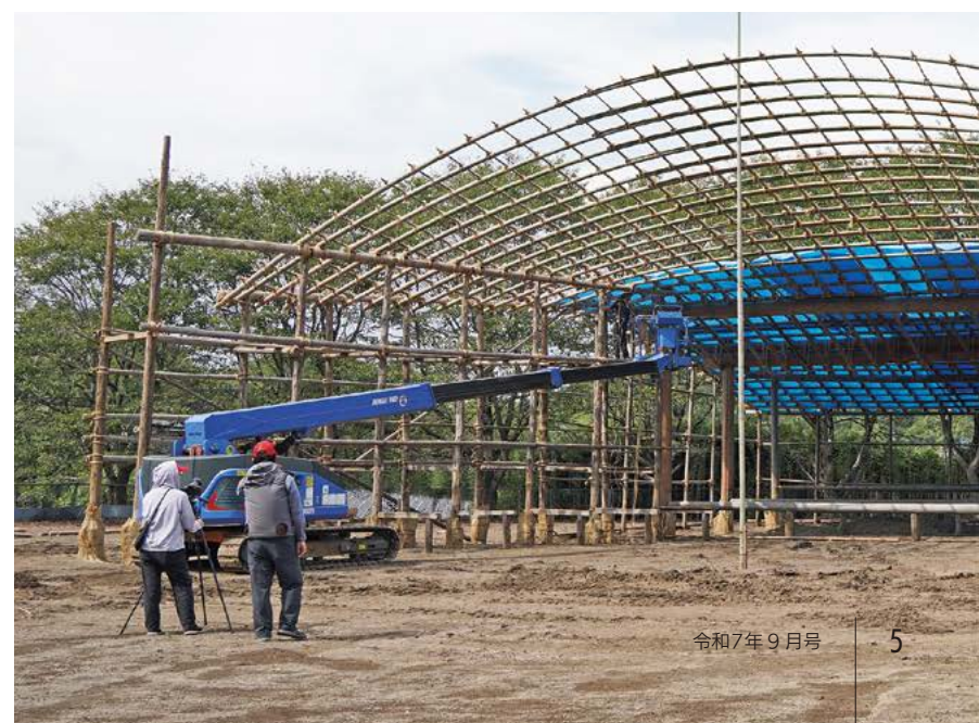
▶今回、運営委員会として特に力を入れているのが、各作業の撮影です。大きな屋根の骨組を縄で結ぶ様子など、次回につなげるために、詳細に記録しているそう。
