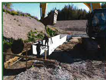
堤外水路を設置しています
