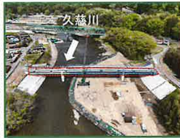
工事箇所の全景（下流から）
