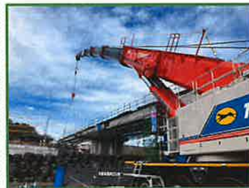
主桁の架設を行っています
