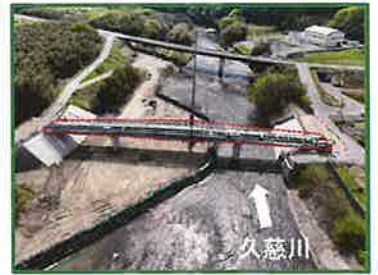
工事箇所の全景（上流から）
