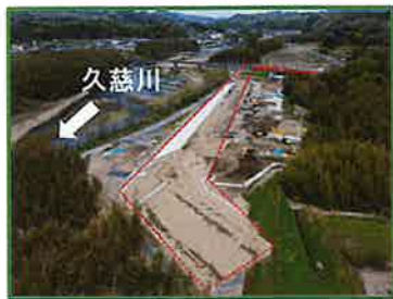
工事箇所の全景（下流から）
