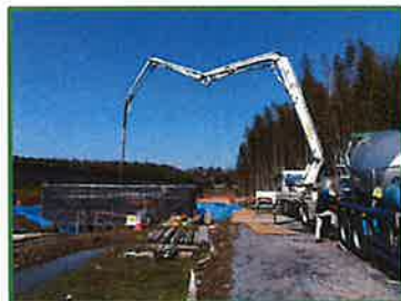
涵渠のコンクリートを打設しています
