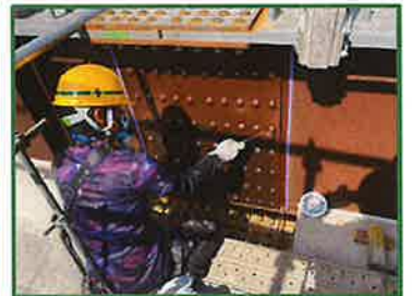
主桁の塗装を行っています
