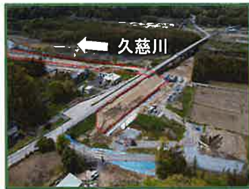
工事箇所の全景（上流から）
