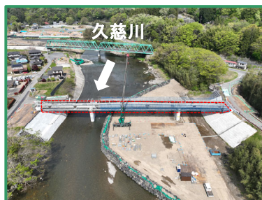
工事箇所の全景（下流から）
