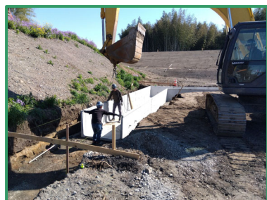
堤外水路を設置しています
