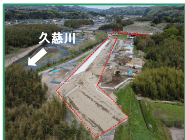
工事箇所の全景（下流から）
