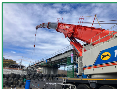
主桁の架設を行っています
