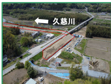
工事箇所の全景（上流から）
