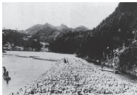
▲大正期の辰ノ口堰と瀬割堤 （『水戸藩利水史料集』より転載）
