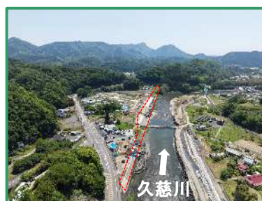
工事箇所の全景（上流から）
