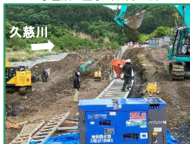
ブロック積みを行っています
