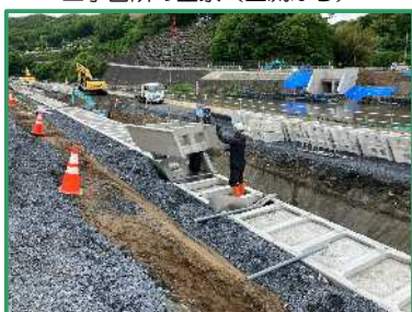
ブロック積みを行っています
