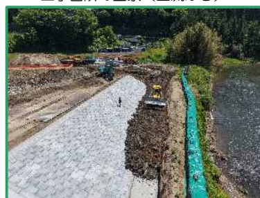
護岸ブロックの埋戻しを行っています
