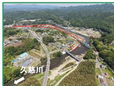
工事箇所の全景（下流から）
