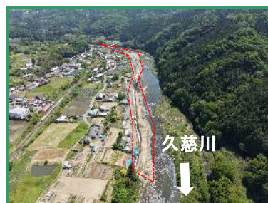
工事箇所の全景（下流から）
