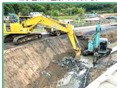
護岸基礎の床掘を行っています
