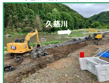
仮締切りを撤去しています
