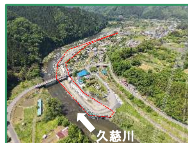
工事箇所の全景（上流から）
