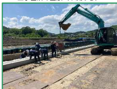
ブロック積みを行っています
