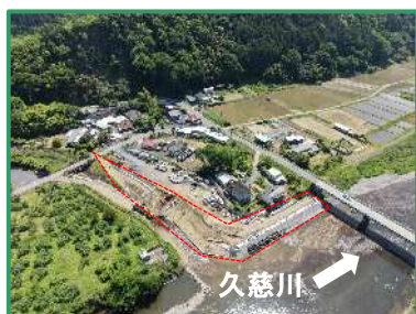
工事箇所の全景（右岸から）
