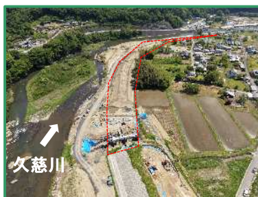
工事箇所の全景（上流から）
