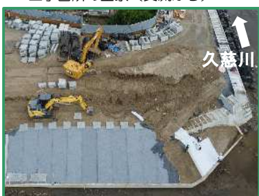
護岸ブロックを設置しています
