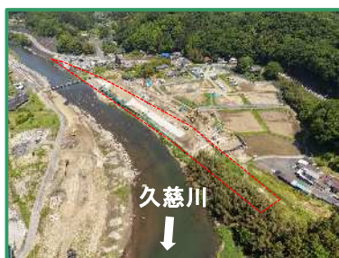
工事箇所の全景（下流から）
