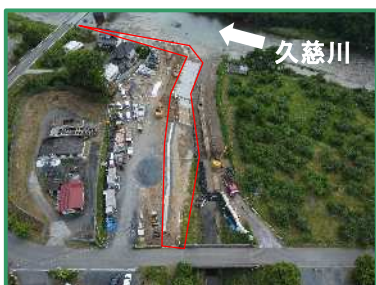
工事箇所の全景（支流から）
