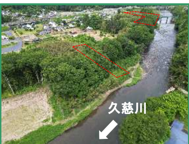
工事箇所の全景（下流から）
