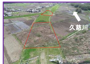
工事箇所の全景（上流から）
