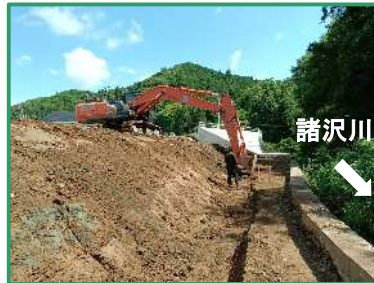
基礎ブロックの床掘を行っています
