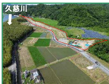
工事箇所の全景（下流から）
