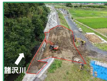
工事箇所の全景（上流から）
