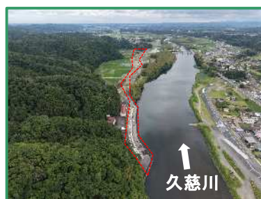
工事箇所の全景（上流から）
