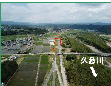
工事箇所の全景（下流から）
