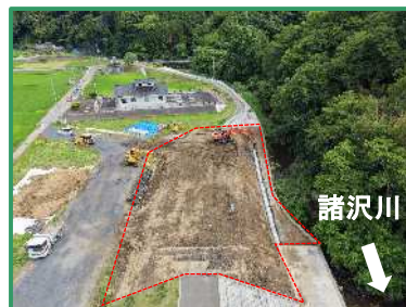
工事箇所の全景（下流から）
