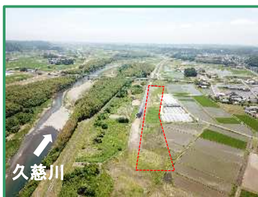
工事箇所の全景（上流から）
