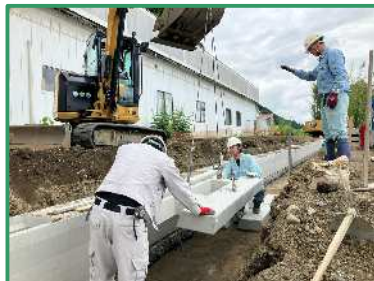
ブロック積みを行っています
