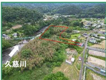
工事箇所の全景（上流から）
