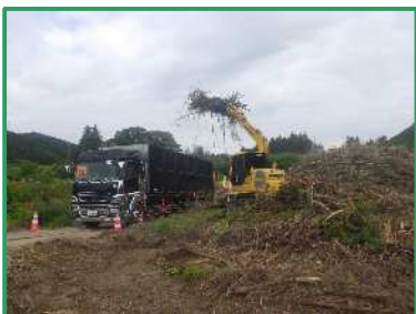
竹根の構込み作業を行っています
