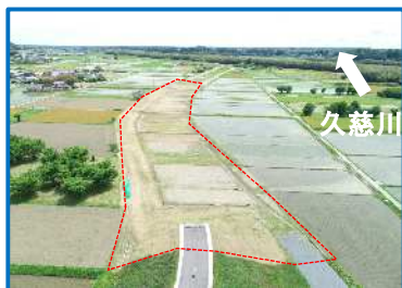
工事箇所の全景（上流から）
