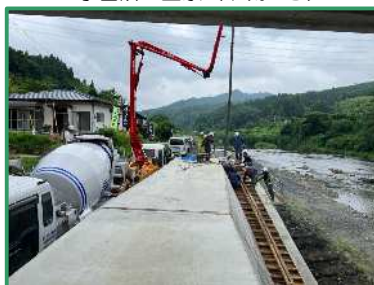
擁壁工のコンクリートを打設しています
