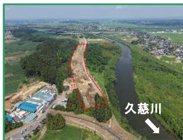
工事箇所の全景（下流から）
