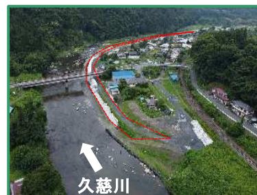
工事箇所の全景（上流から）
