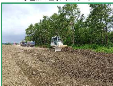
工事用道路の整備を行っています
