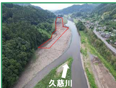
工事箇所の全景（上流から）
