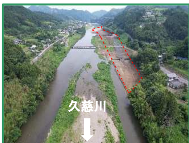
工事箇所の全景（下流から）
