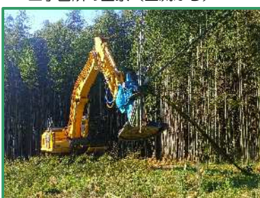
竹林の伐採作業を行っています
