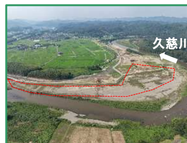
工事箇所の下流全景（右岸から）
