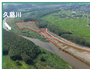
工事箇所の上流全景（右岸から）
