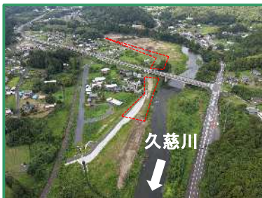
工事箇所の全景（下流から）
