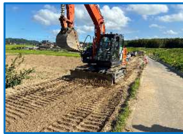
仮設坂路の拡幅を行っています
