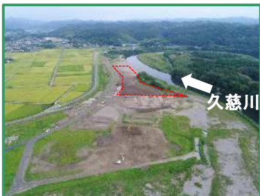
工事箇所の全景（上流から）
