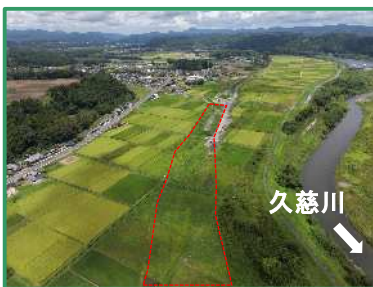
工事箇所の全景（下流から）
