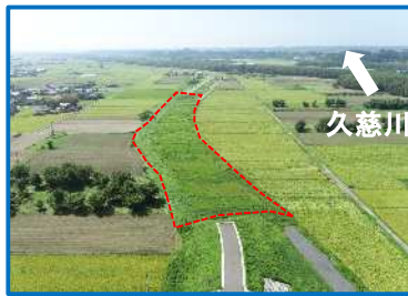
工事箇所の全景（上流から）
