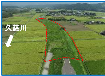
工事箇所の全景（下流から）
