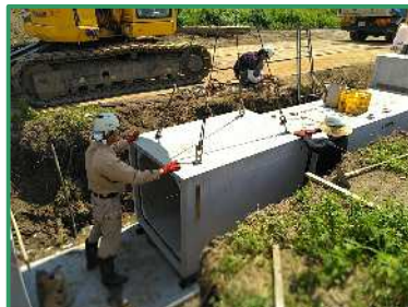
ボックスカルバートを設置しています
