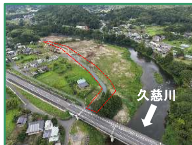
工事箇所の全景（上流から）
