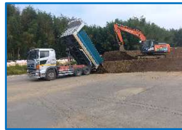
築堤土の受け入れを行っています
