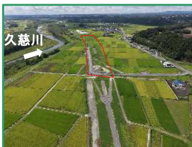
工事箇所の全景（上流から）
