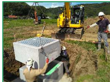
集水枡を設置しています
