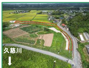
工事箇所の上流全景（下流から）
