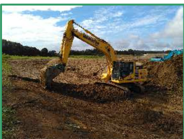
土砂の掘削作業を行っています
