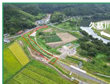
工事箇所の下流全景（上流から）
