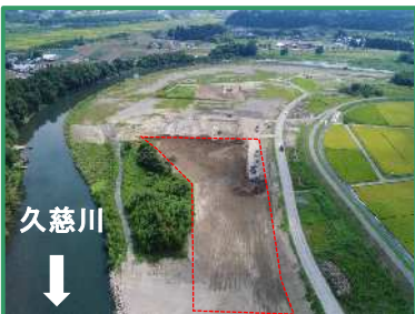
工事箇所の全景（下流から）
